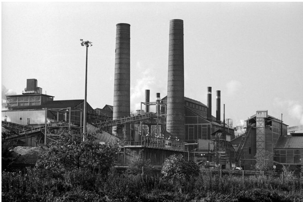
Vue partielle, flanc est.
