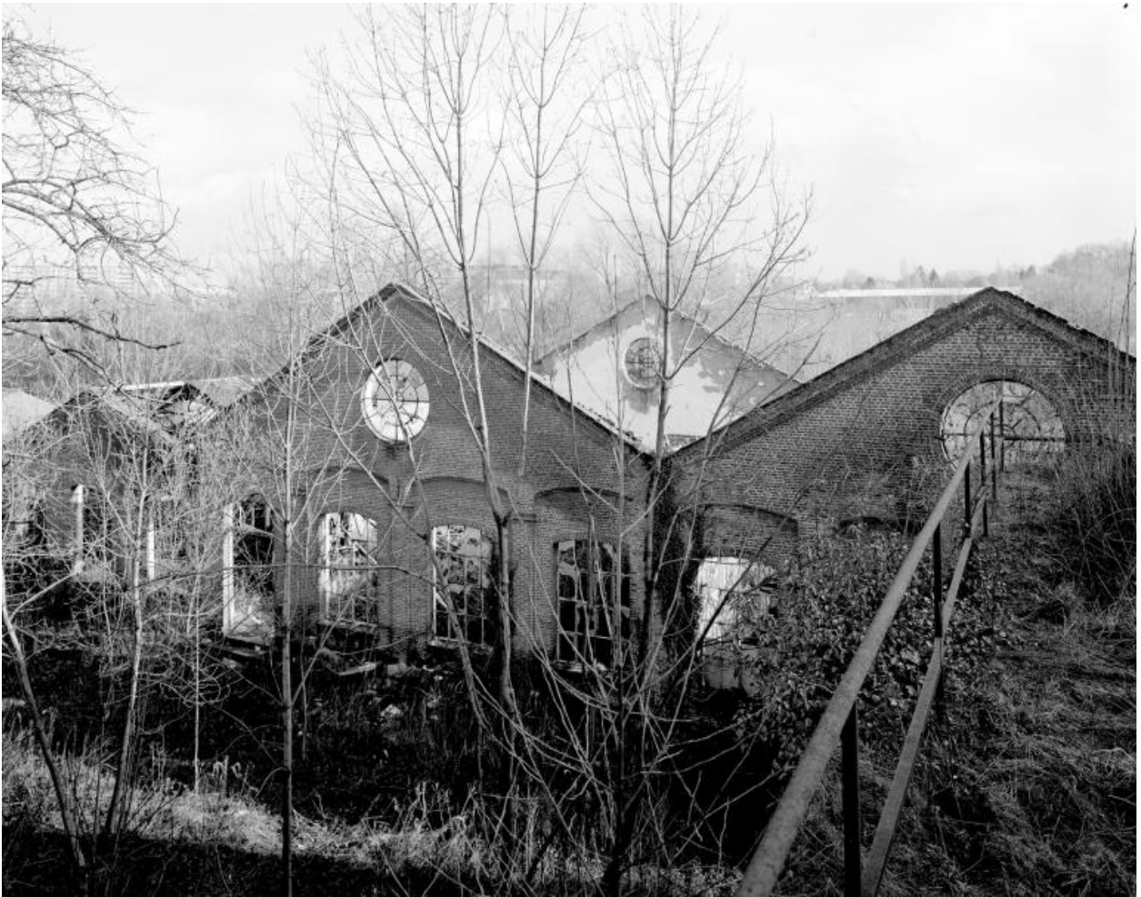
Sous-station électrique. Vue prise depuis la conciergerie.
