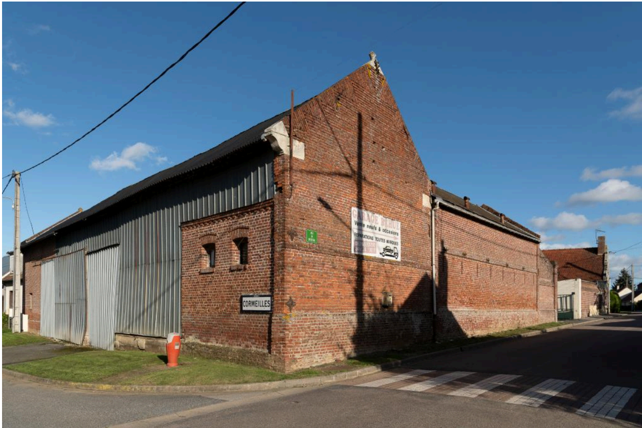
Ferme, n°3 rue de Breteuil, vue depuis le sud-ouest.
