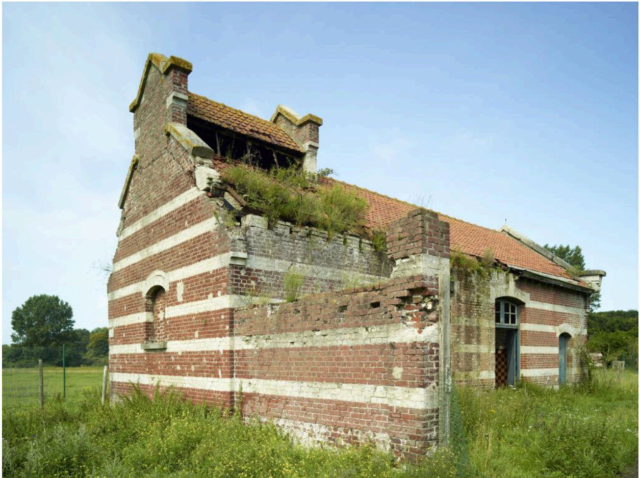
Abattoir, vue d'ensemble sud-est.
