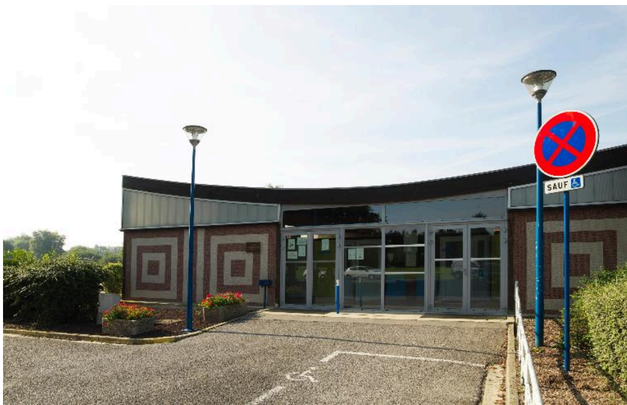
Façade d'entrée (nord).
