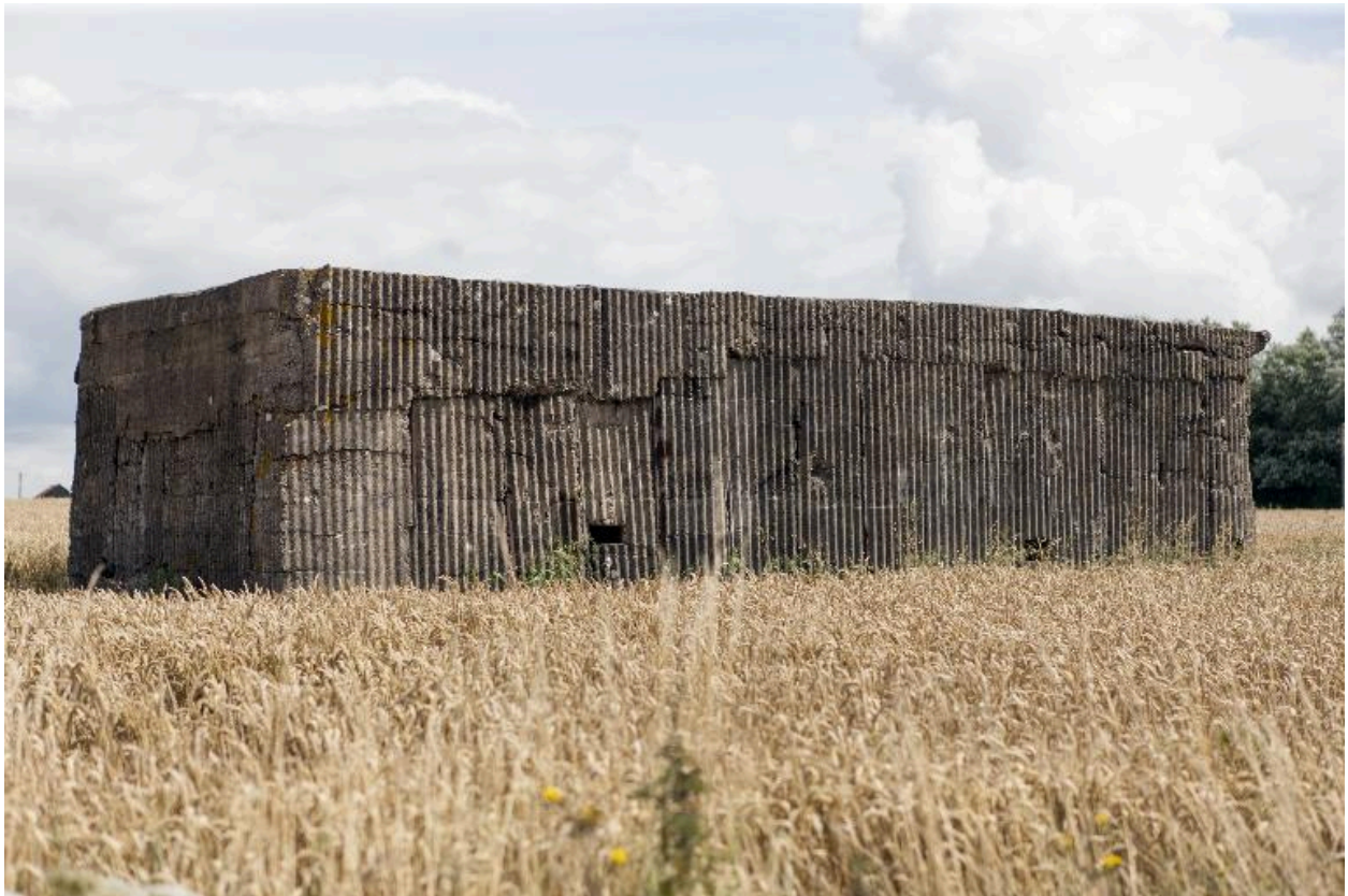
Vue de trois-quarts arrière, vers l'est
