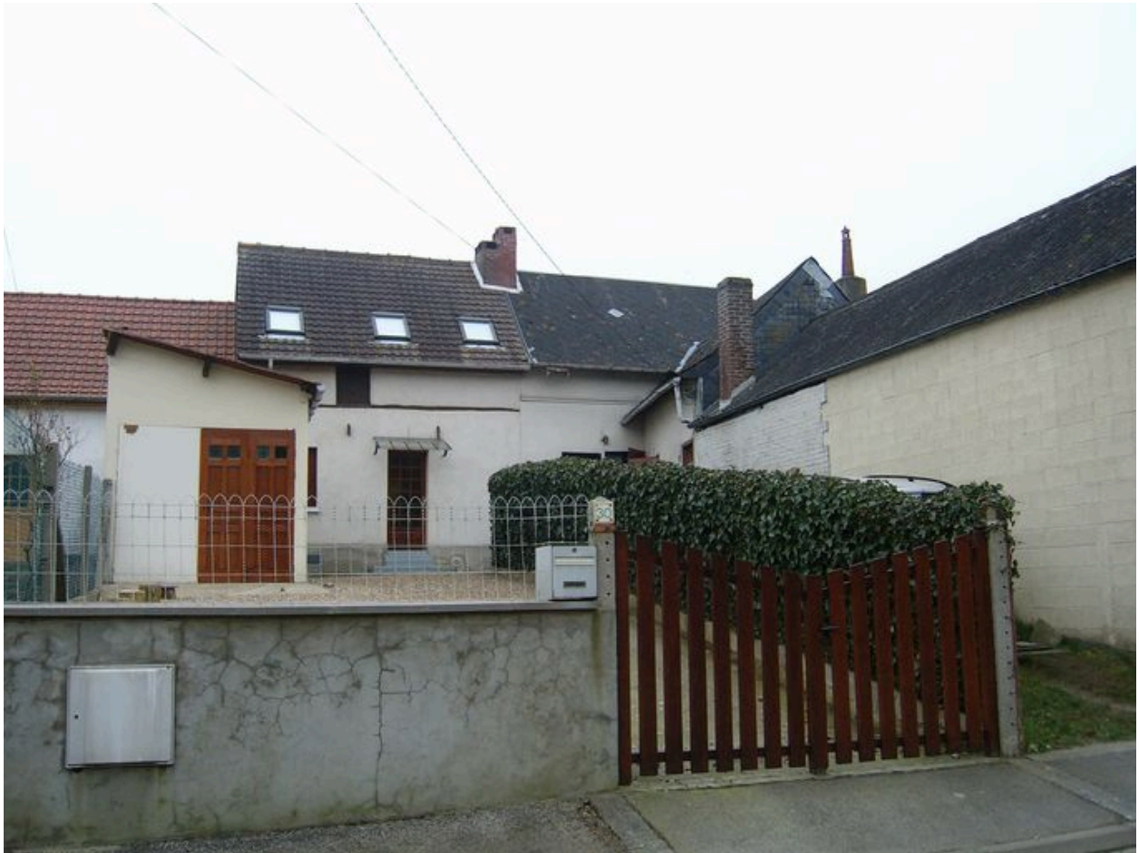
Ancienne ferme, 28 rue du Canal (1982 A3 359).
