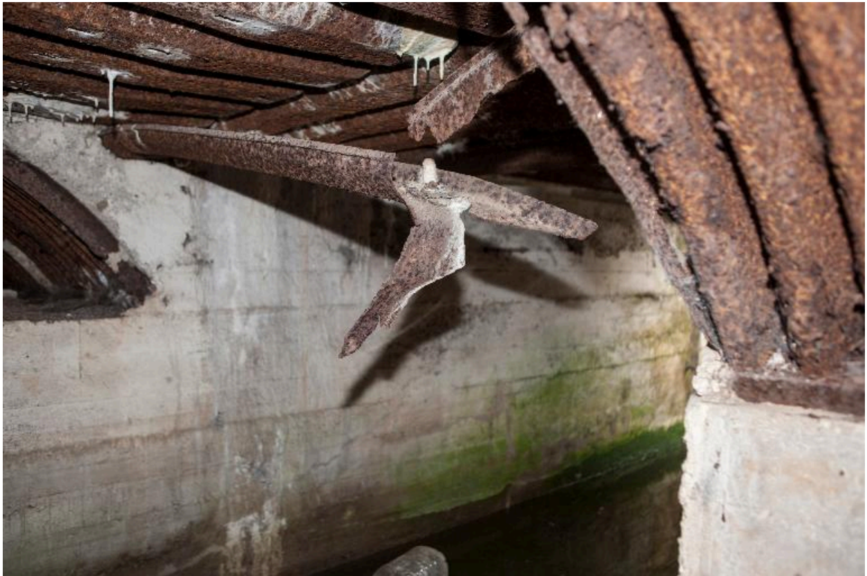
Détail d'une tôle de coffrage
