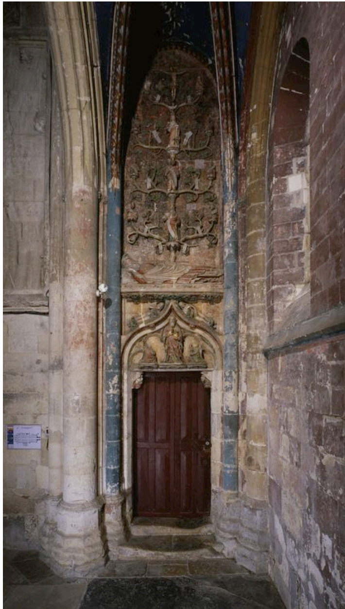
Vue générale, avant restauration.
