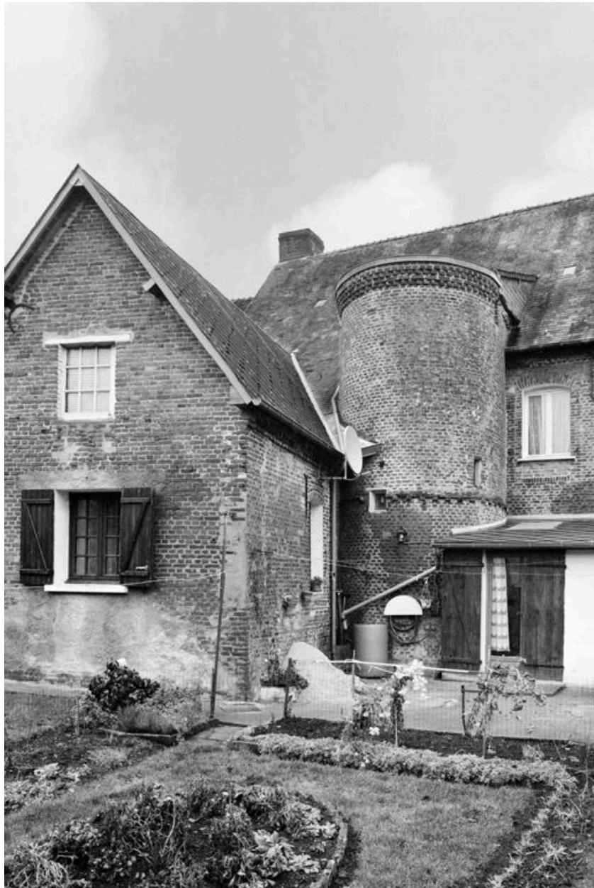
Détail de l'escalier hors-oeuvre de l'élévation postérieure sur le jardin.
