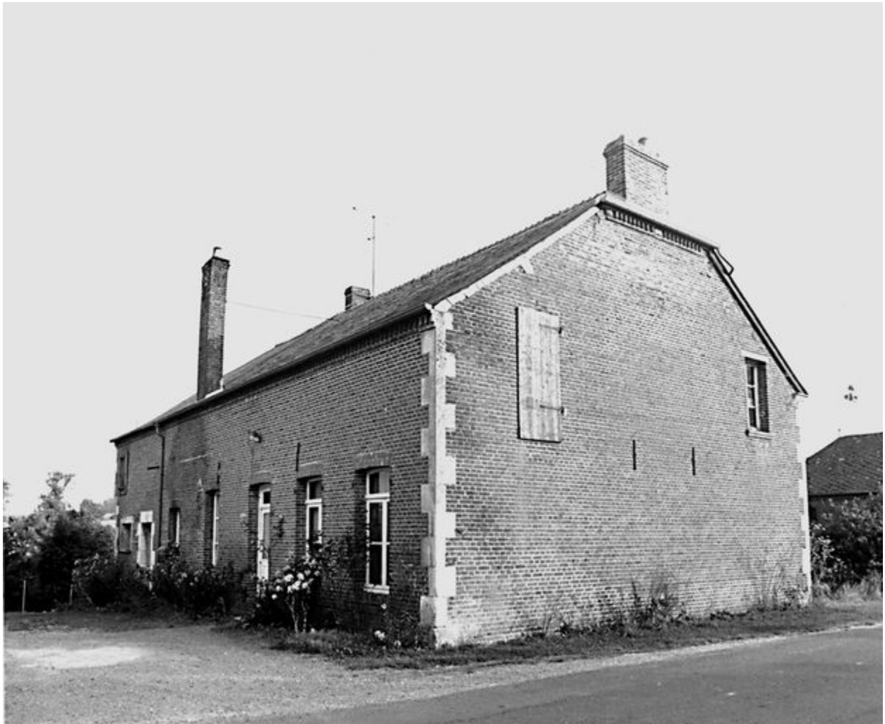
Elévation postérieure du logis.
