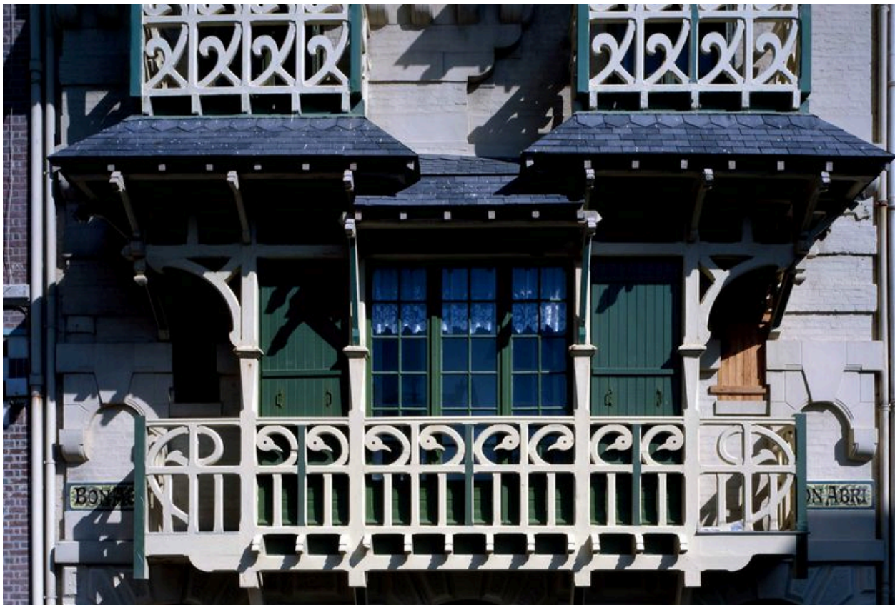
Détail des balcons.
