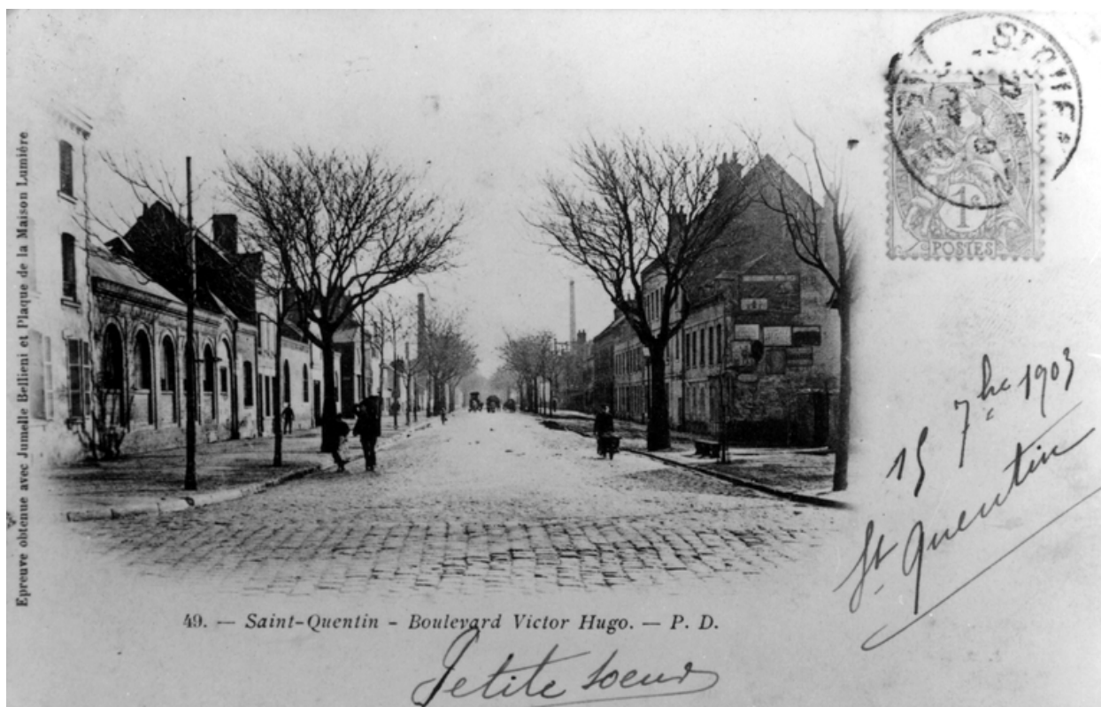
Carte postale, 1903. A gauche, façade des ateliers (6 ouvertures couvertes en plein-cintre), boulevard Victor-Hugo (BM Saint-Quentin).
