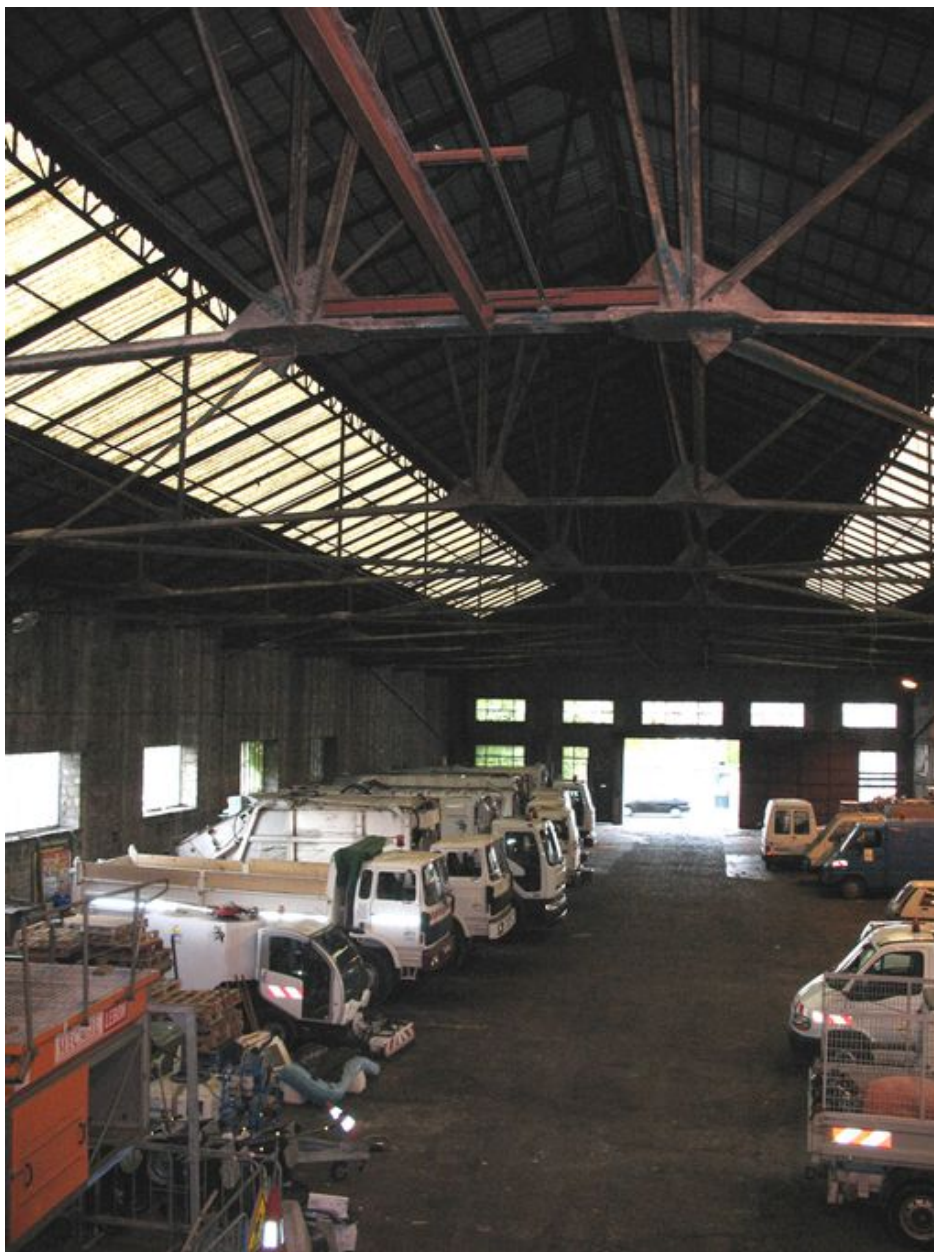
Intérieur des ateliers vu vers le nord.
