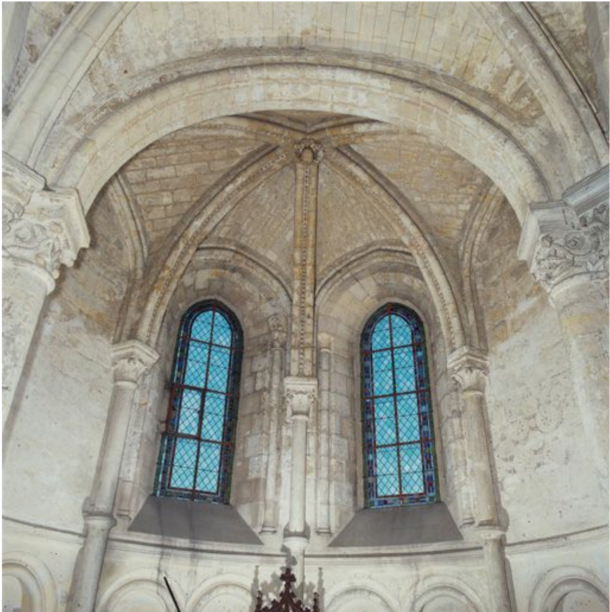
Vue intérieure du déambulatoire, chapelle rayonnante.
