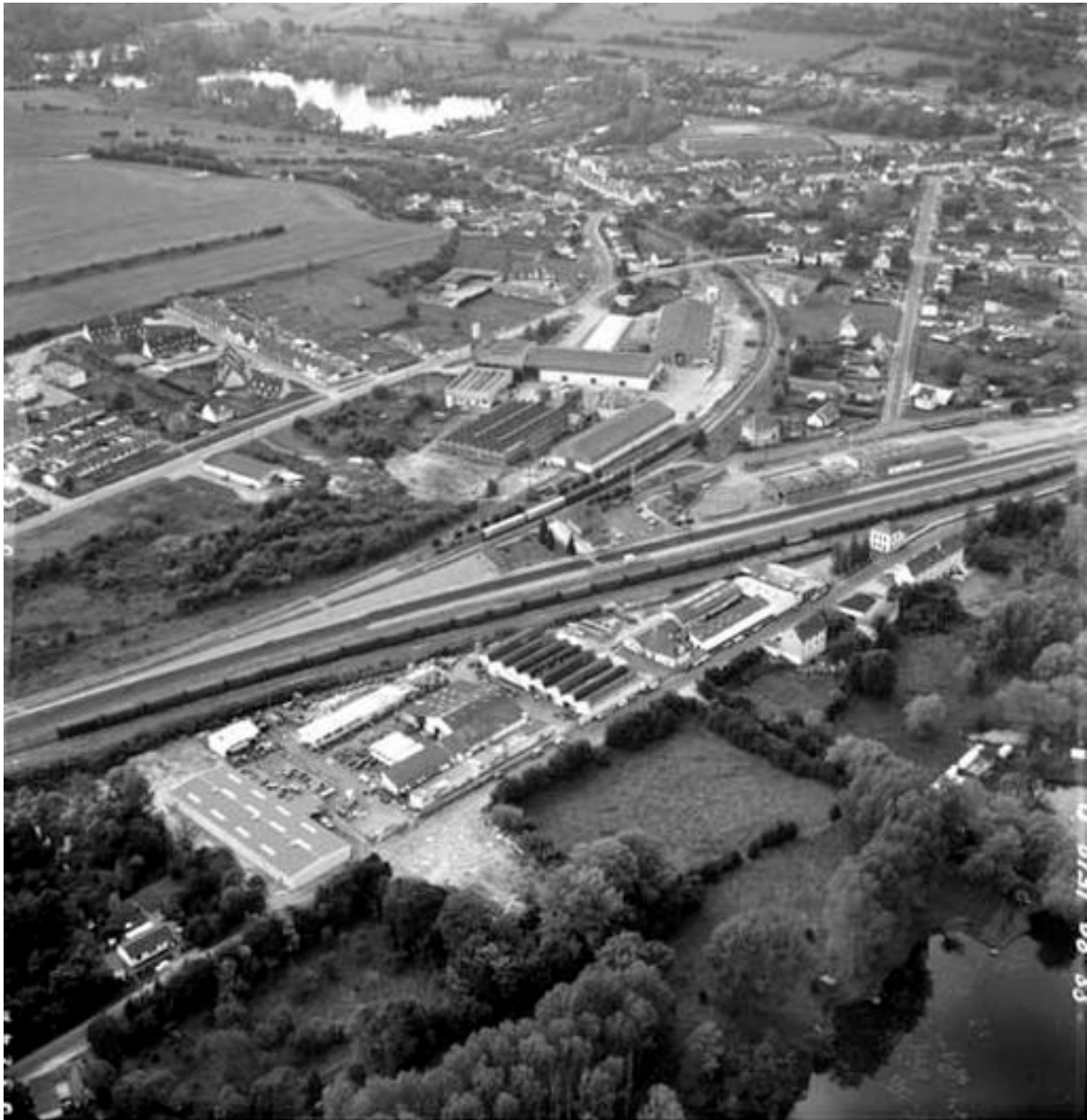
Vue aérienne, flanc nord-est.
