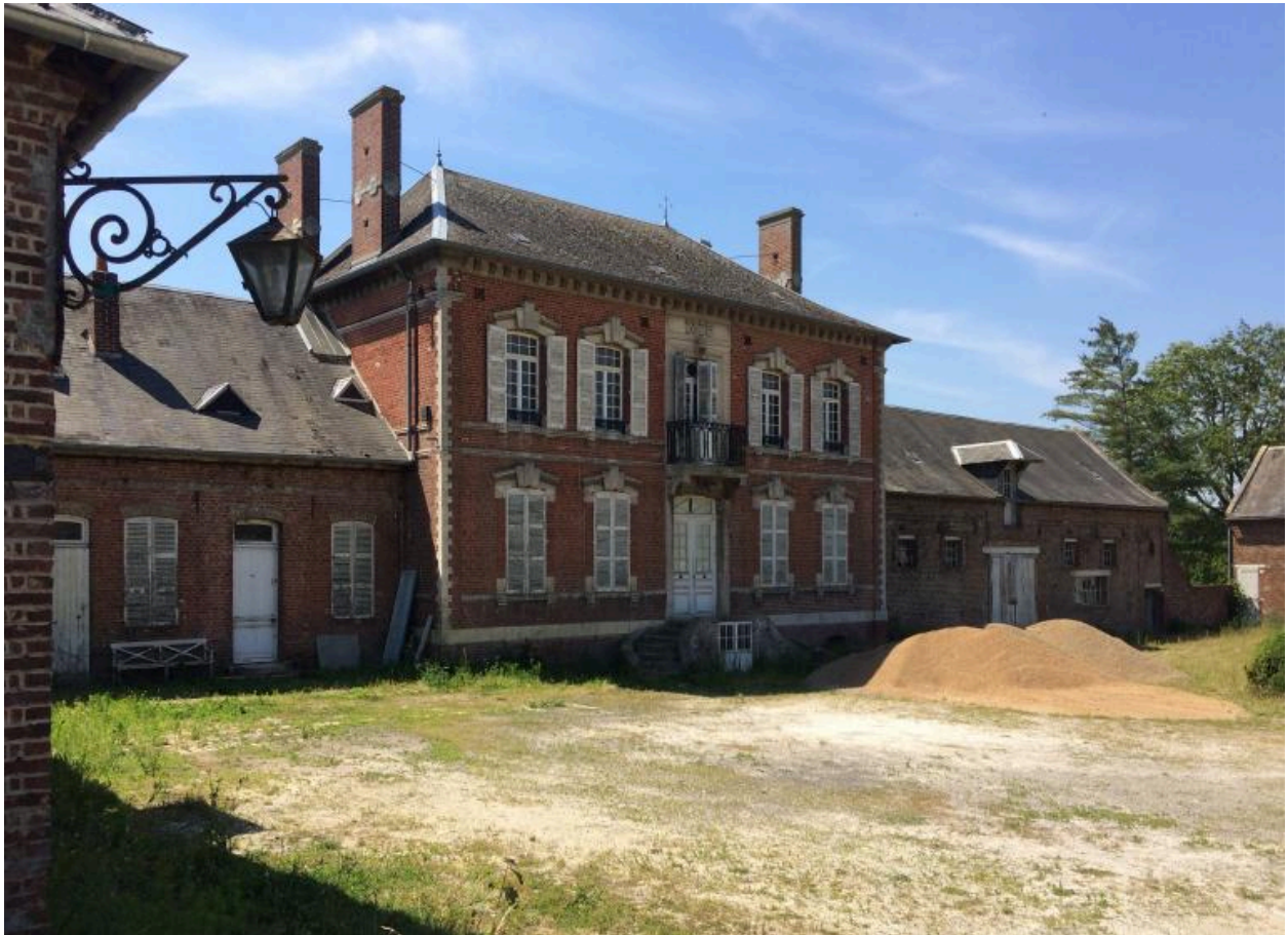
Vue du logis depuis l'entrée de la cour.
