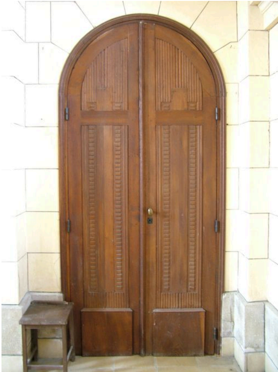
Vue de la porte de la sacristie.
