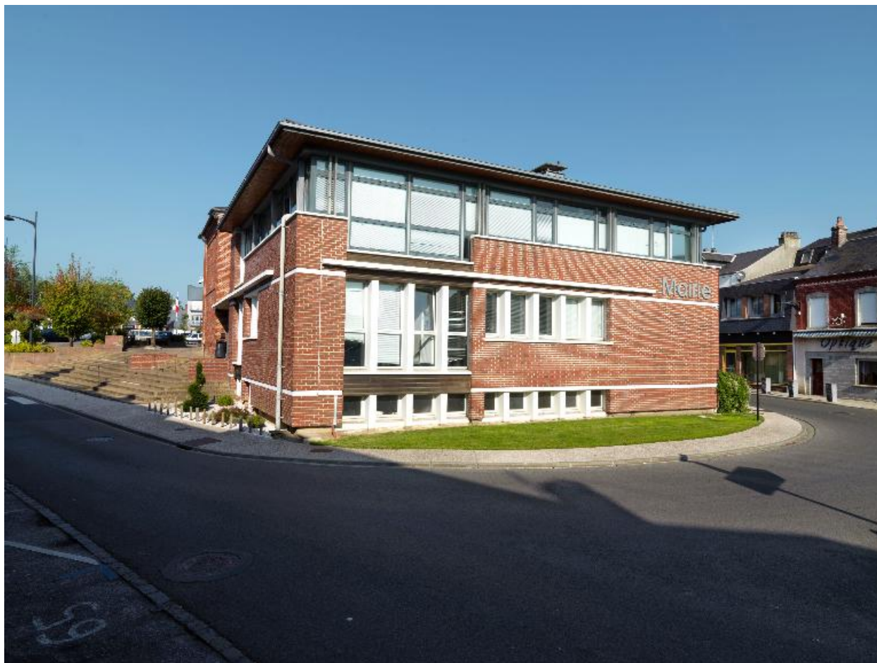
Vue des extensions de la mairie d'Escarbotin.
