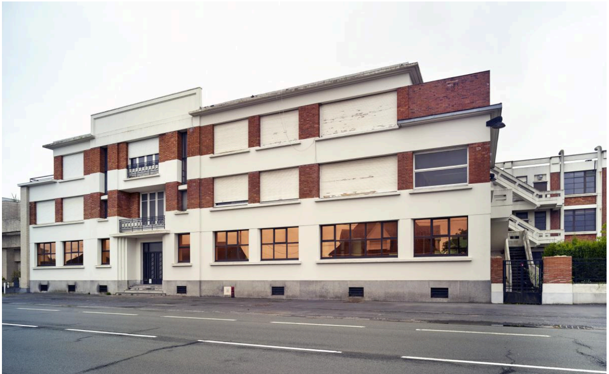
Bâtiment des bureaux et logements (E). Elévation sur rue, vers le sud-est.
