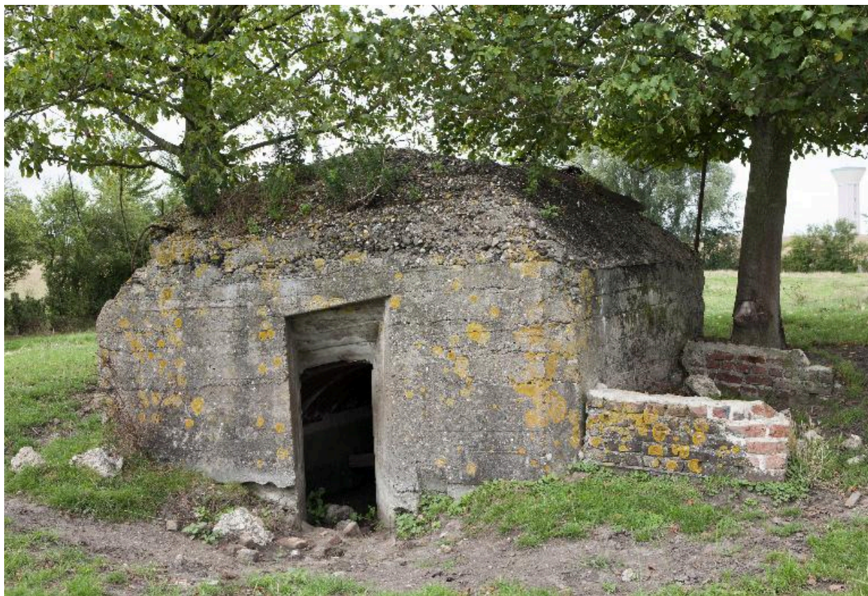
Elévation sud, entrée
