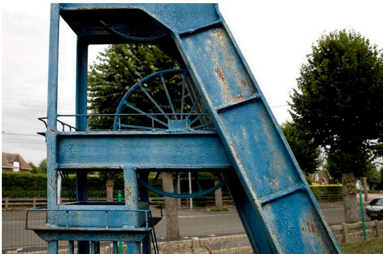
Chevalement du 7 d'Avion, détail.
