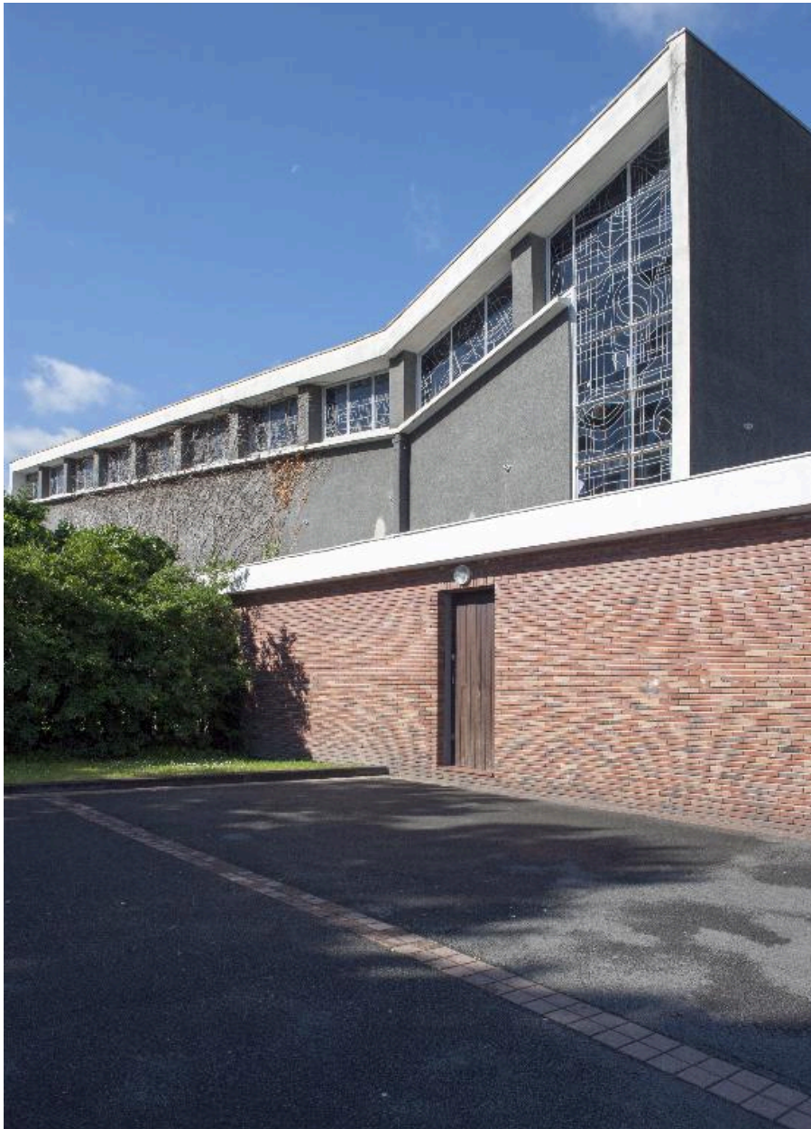
Vue du flanc droit de l'église.
