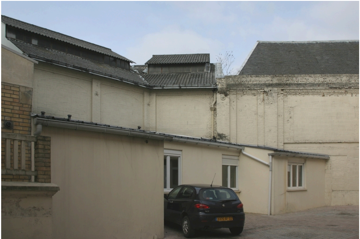
Vue de l'ancienne fonderie depuis la cour.
