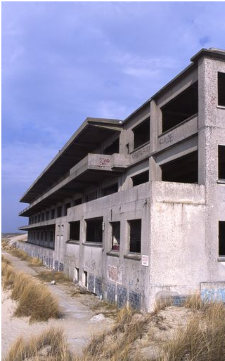
Élévation antérieure, vue générale prise en enfilade à partir du flanc droit.
