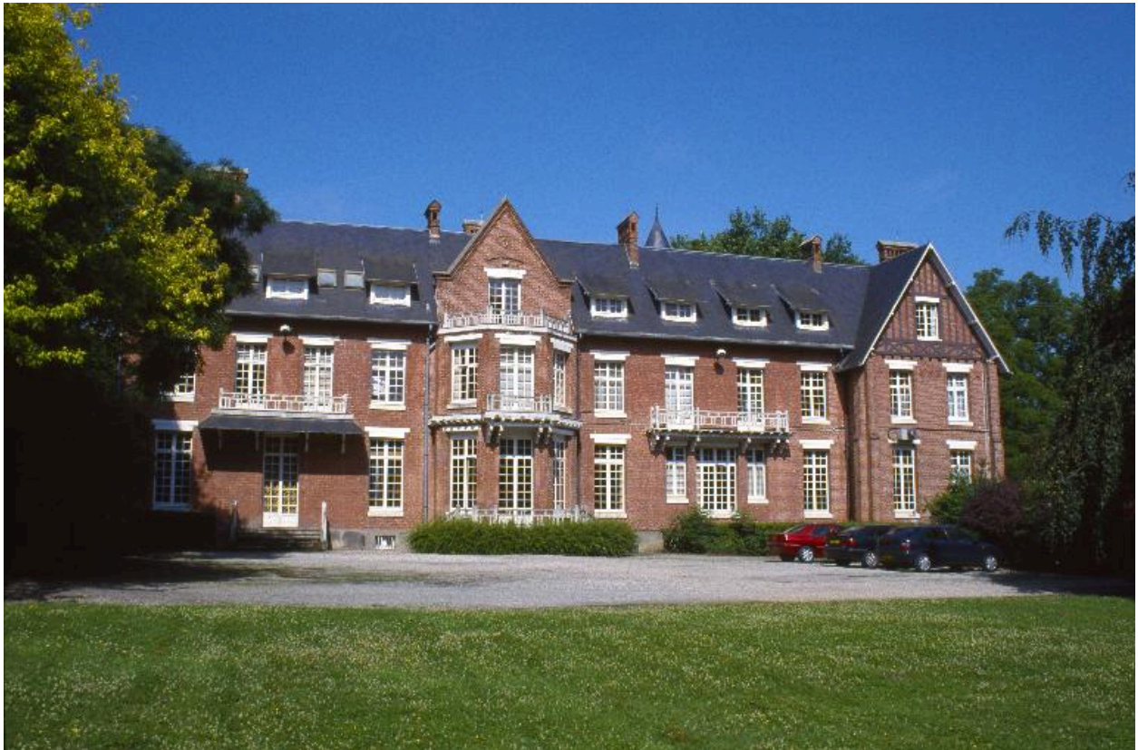
Vue d'ensemble de la façade principale.
