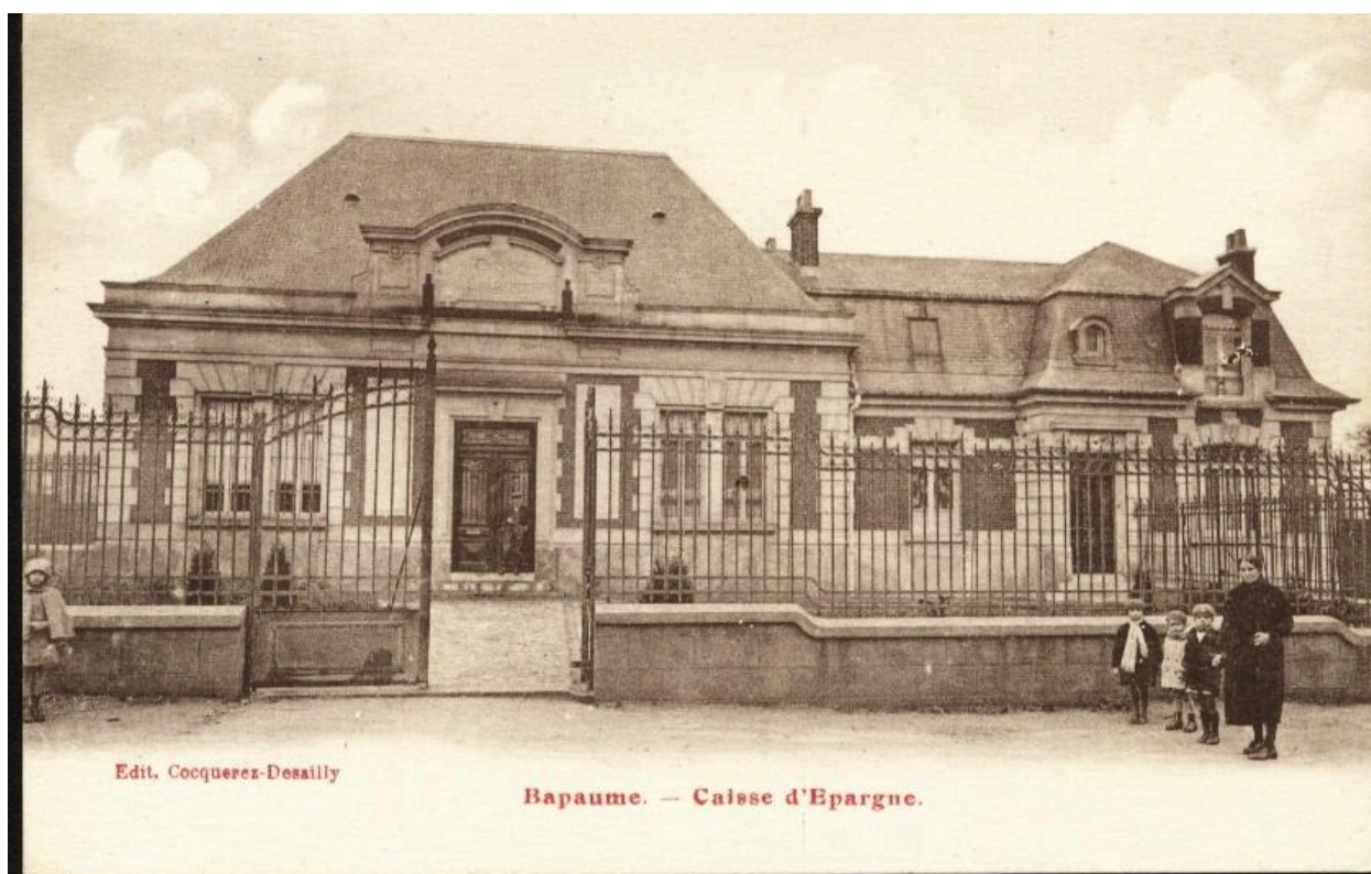
Bapaume - Caisse d'Epargne. Editions Coquerez-Dessailly. Carte postale, vers 1930 (coll.part.). Façade principale et mur-bahut sur la rue de la république.
