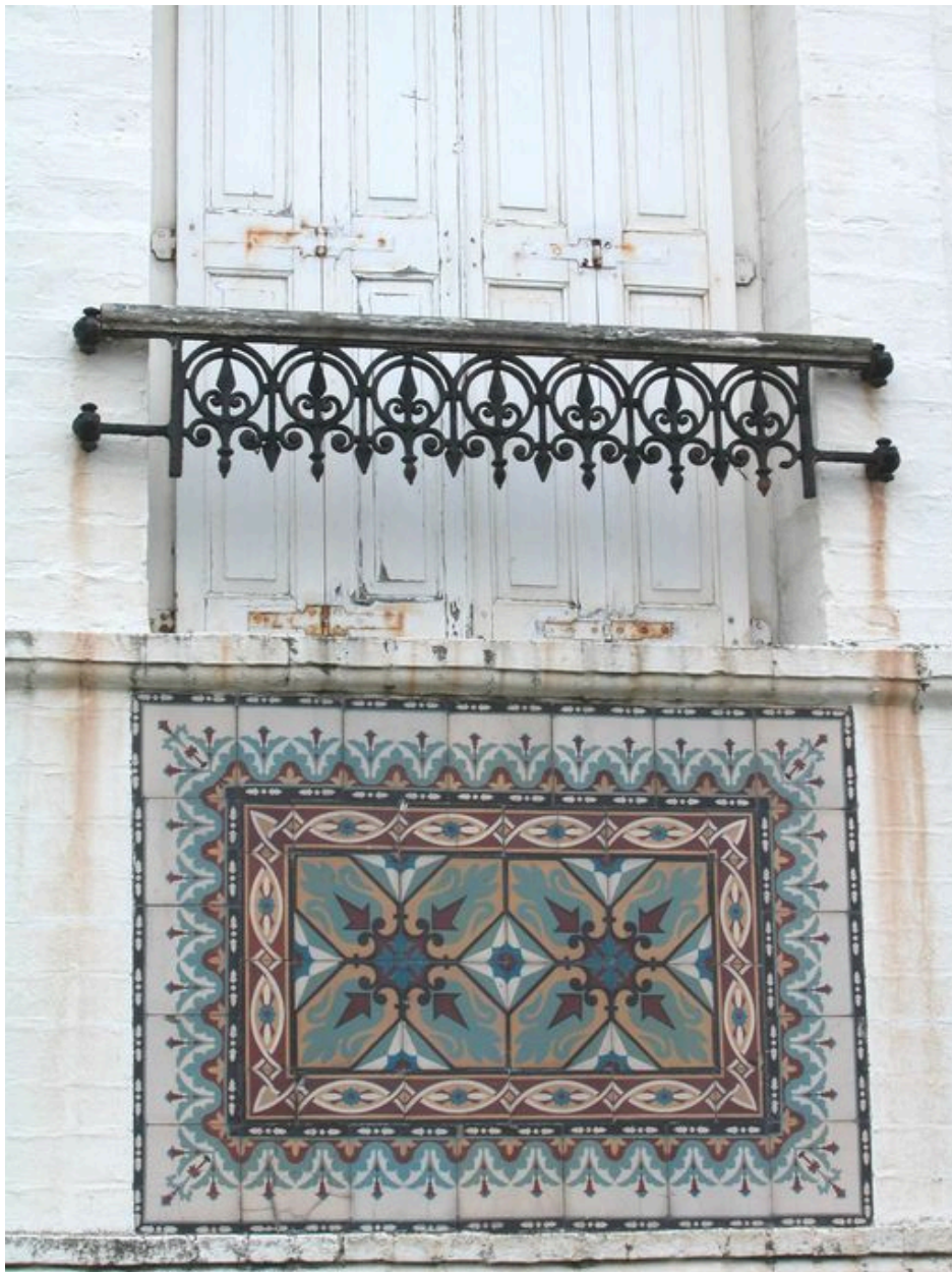
Détail du décor de fonderie et de céramique d'une baie.
