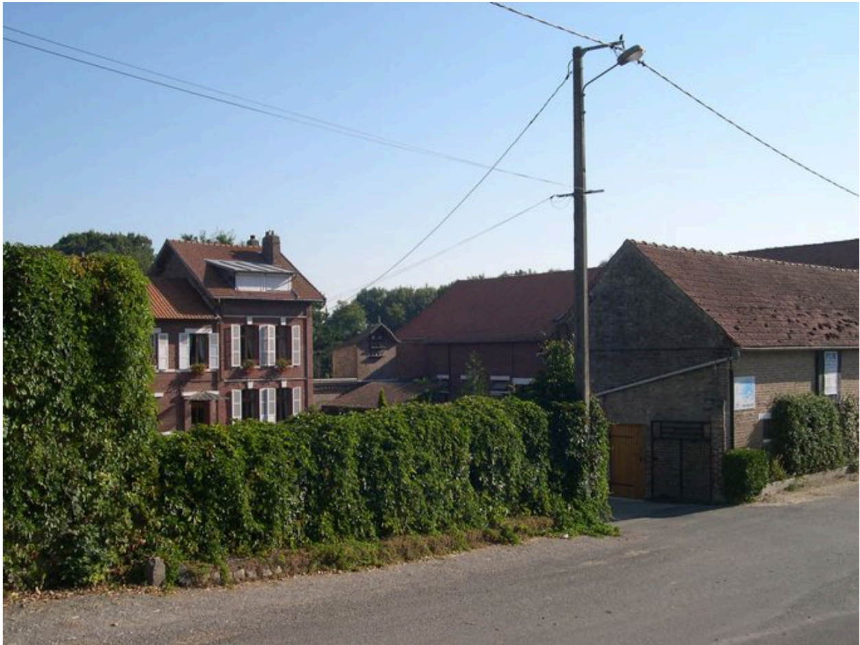
La ferme du château, vue du sud-ouest.
