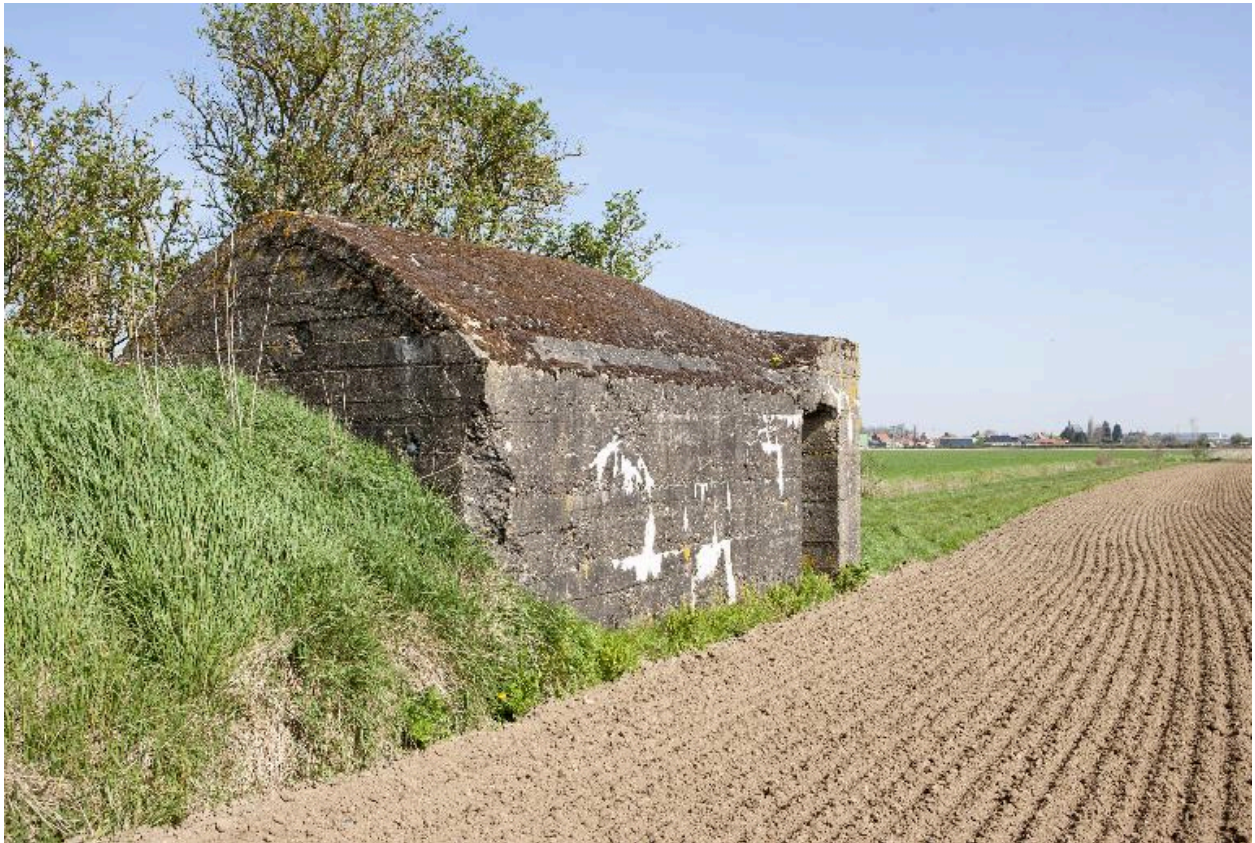
Bâtiment 4, élévation sud-est. A gauche le bâtiment 3 ?
