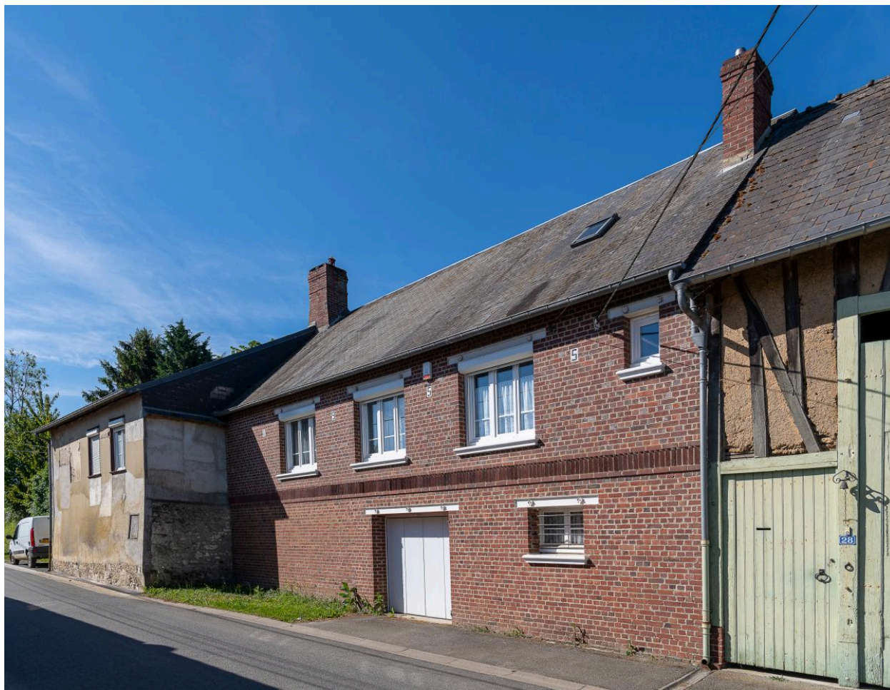
Maison datée de 1955 (date portée sur la façade), n°28 rue des Fresnes, vue depuis l'est.
