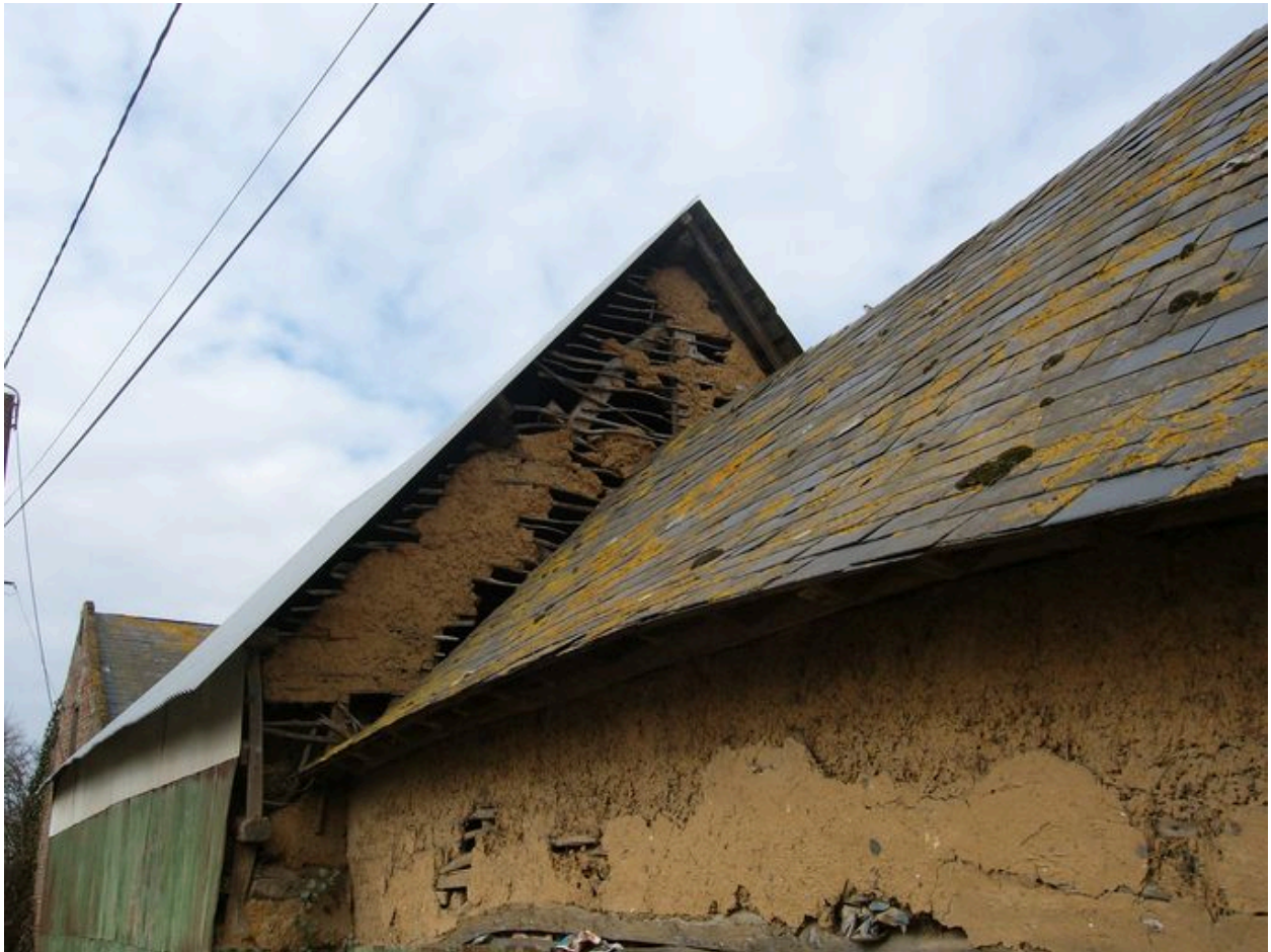
Vue du décrochement du pignon de l'écurie.
