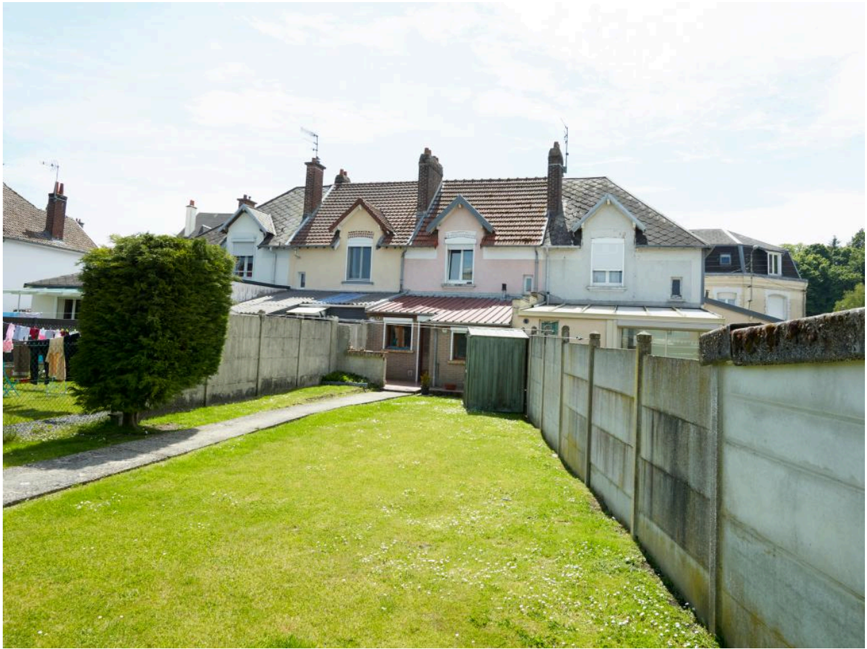
Groupe de quatre logements. Vue générale des façades arrières et des jardins des numéros 25 à 31 des maisons de la rue Marcellin Gaudefroy.
