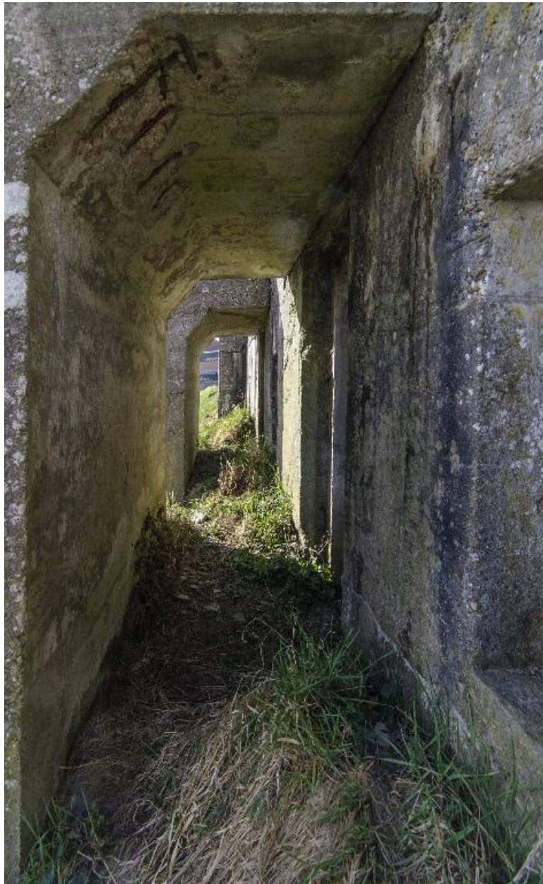
Vue en enfilade au travers des porches pare-souffle
