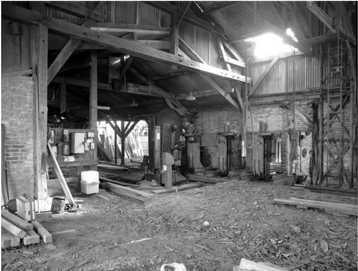
Vue intérieure de l'atelier de fabrication avec les scies à grumes.
