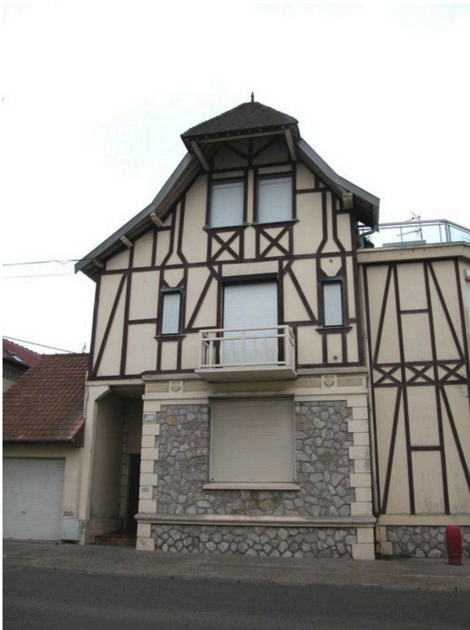
Moellons de pierre apparents en soubassement (Les Fauvettes, 25 avenue Courbet).
