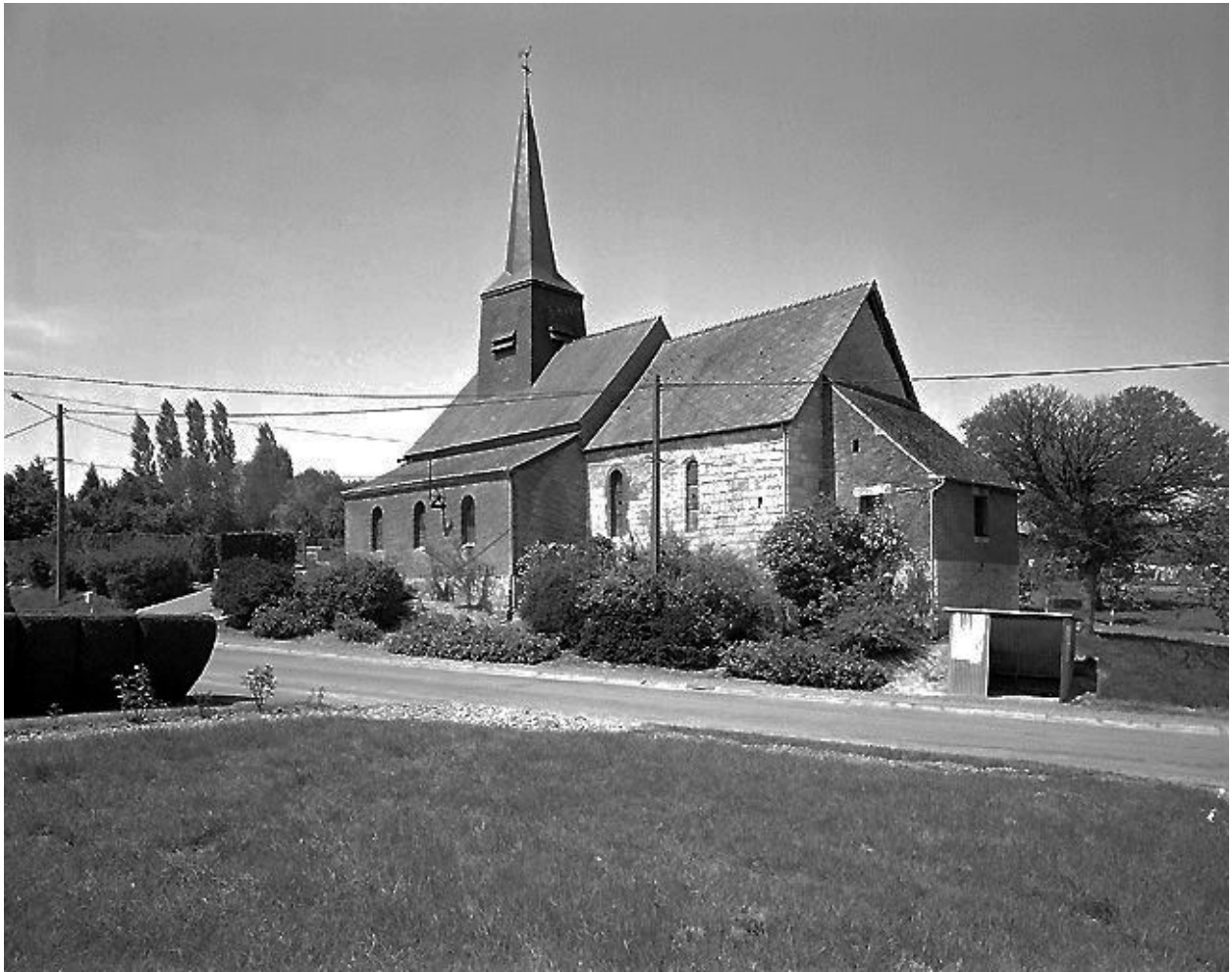
Vue depuis le sud-est.
