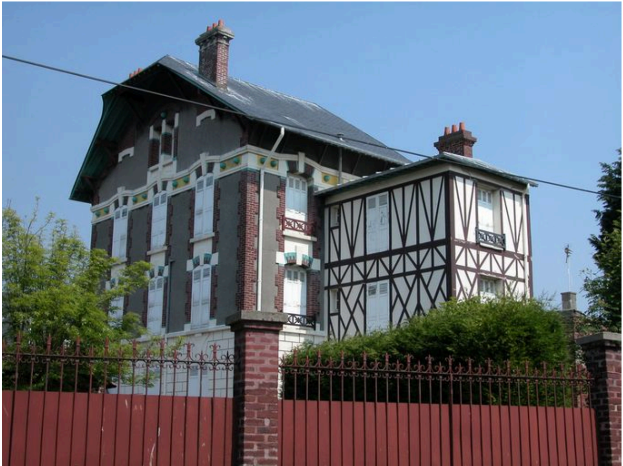
Vue d'ensemble depuis la rue Mennessier.
