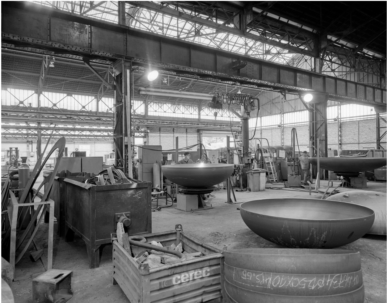
Hall 7 : la mise à hauteur au chalumeau.
