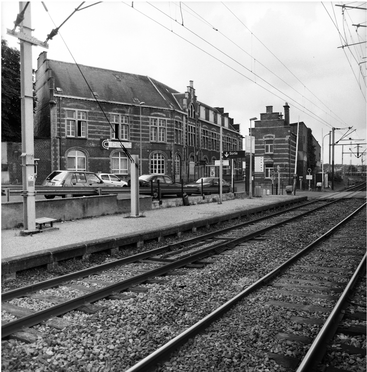
Vue générale des bureaux depuis la voie de chemin de fer.
