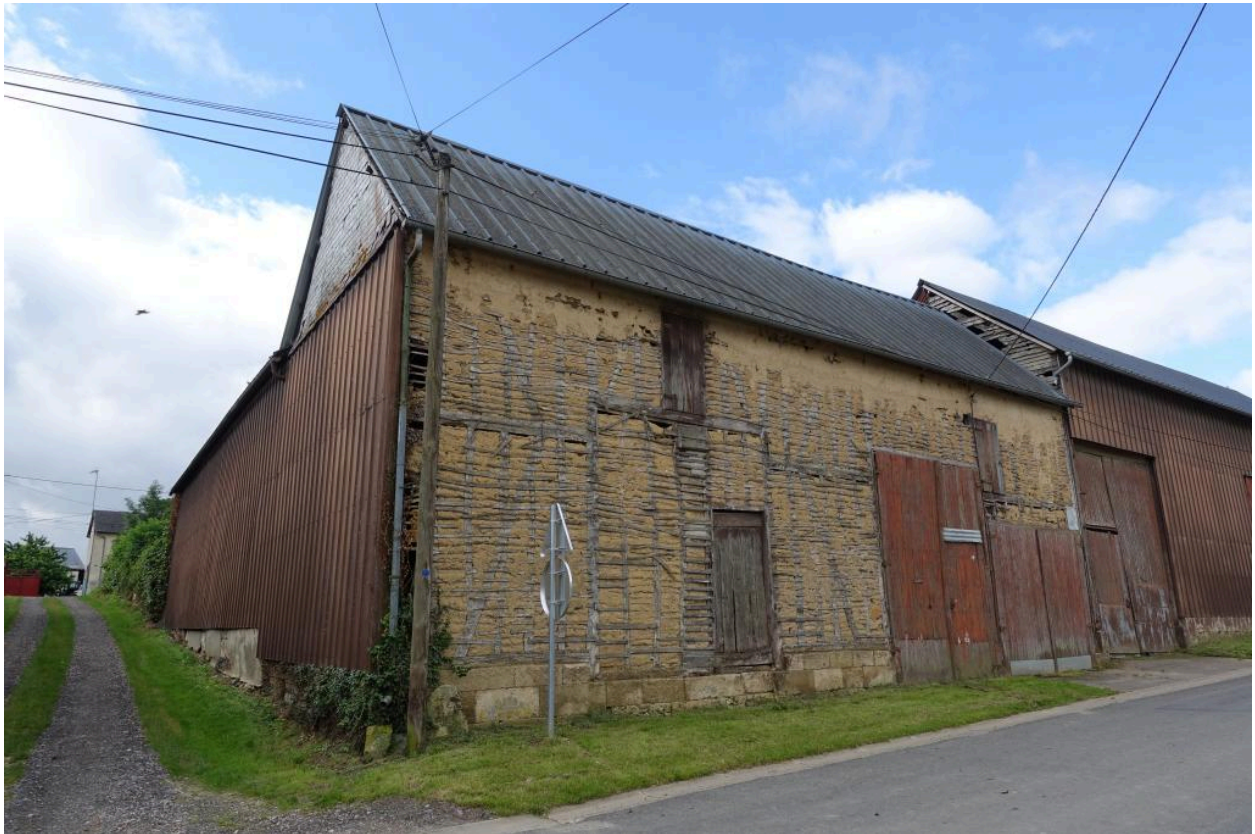
Grange de la ferme au n°41 Grande Rue, vue depuis le nord-est.
