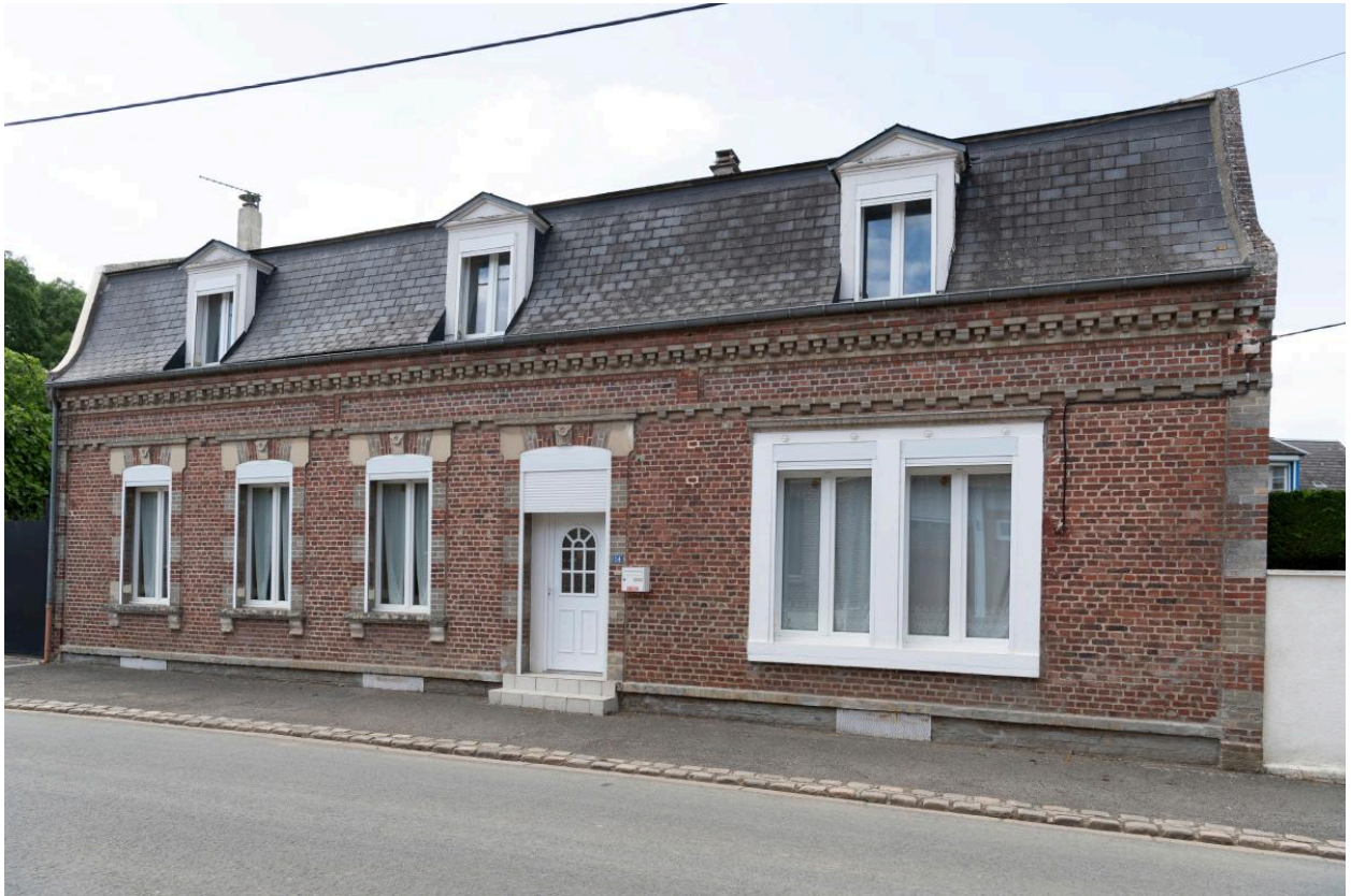
Ancien café de la Gare, n°14 rue de la Gare, vue depuis le sud-est.
