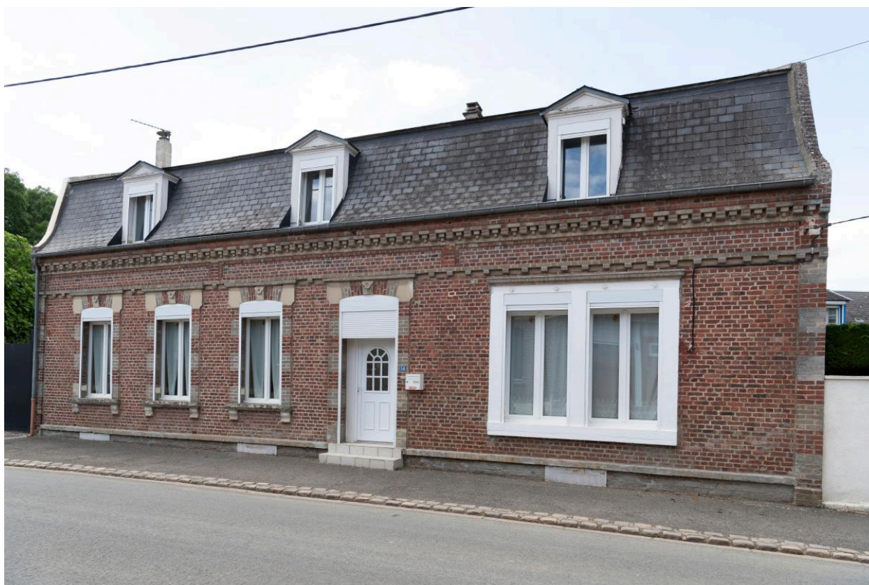
Ancien café de la Gare, n°14 rue de la Gare, vue depuis le sud-est.
