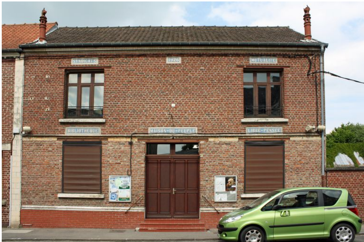
Saint-Ouen, ancienne maison du peuple, 1926.
