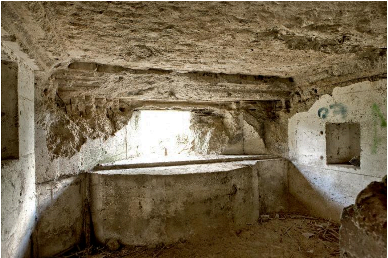
Ouverture et banquette de tir.
