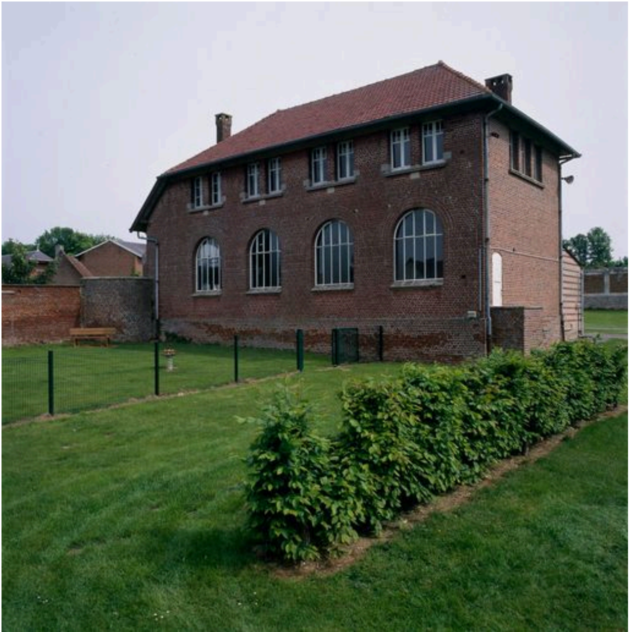
Vue de la façade sud.
