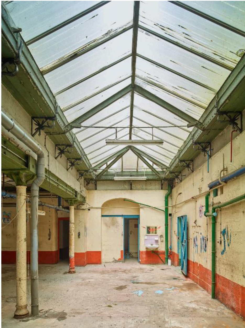
Aile nord, sous-sol. Vue générale du lavoir vers le sud.
