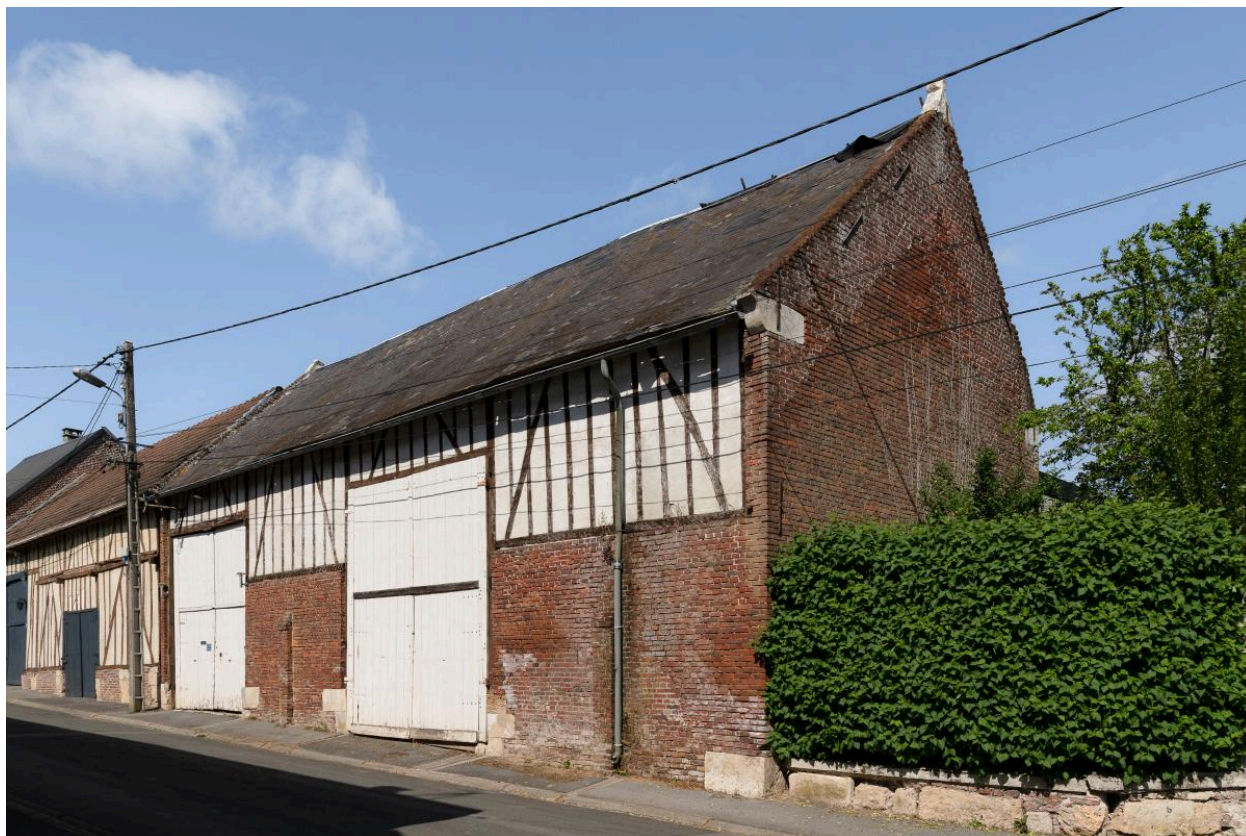
Ancienne grange sur rue avec entrée charretière, n°9 rue Prien, vue depuis le nord-est.
