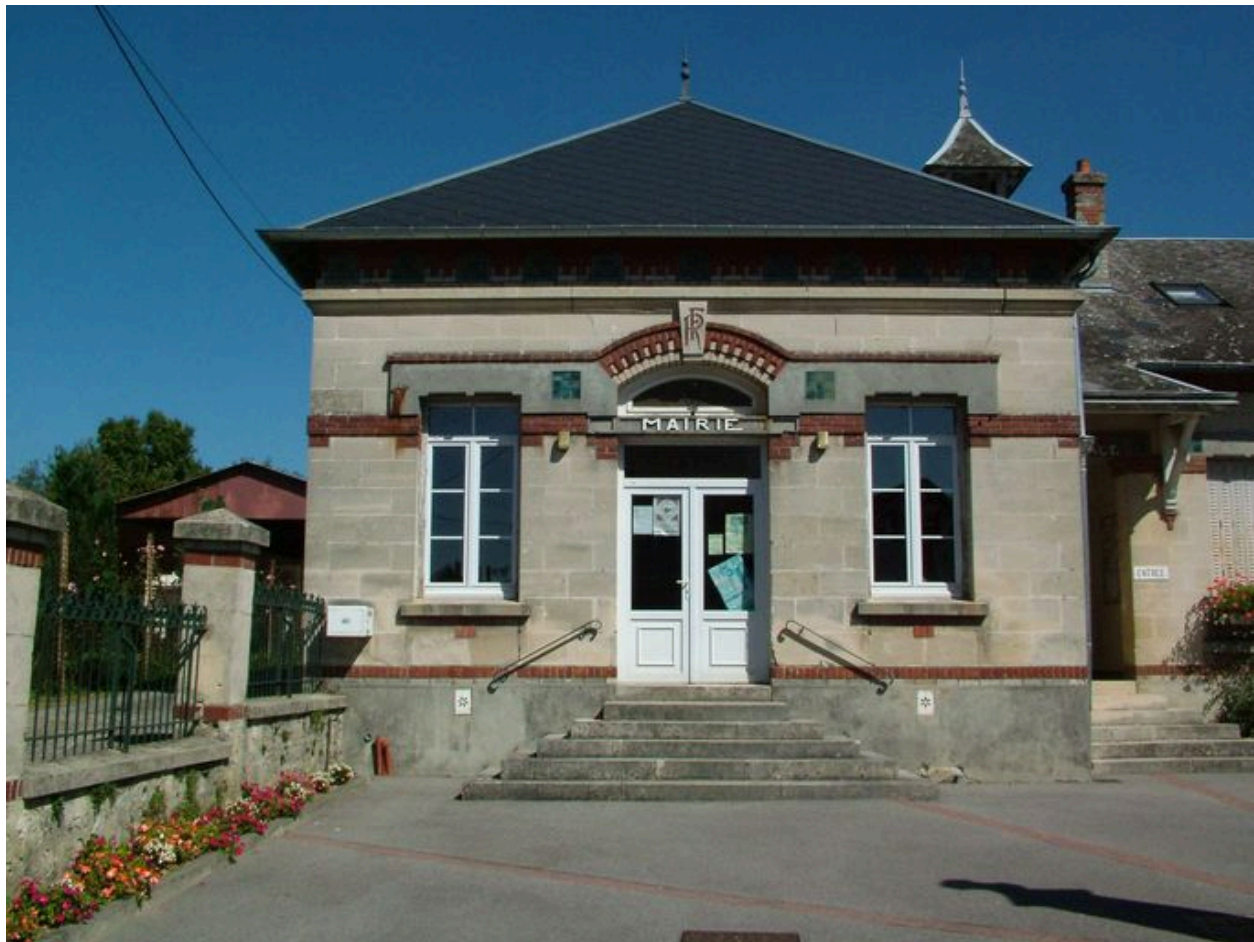
Vue détaillée du bâtiment de la mairie.
