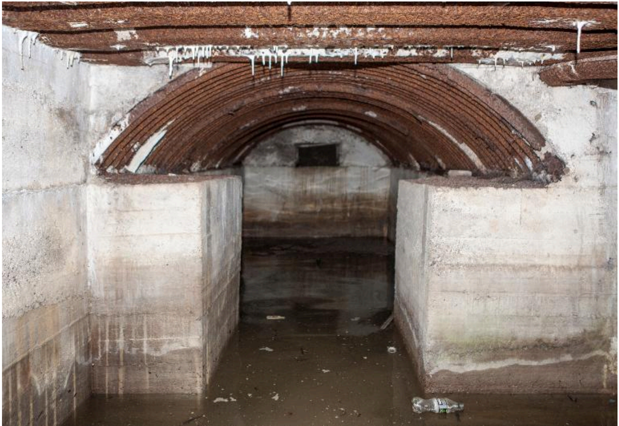
La salle nord, depuis le couloir
