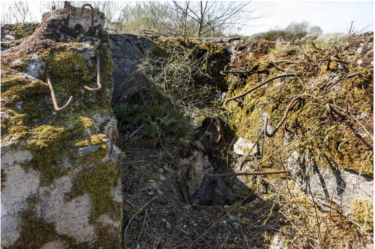
Casemate A. Depuis le couvrent. Débouché de l'accès à la mitrailleuse
